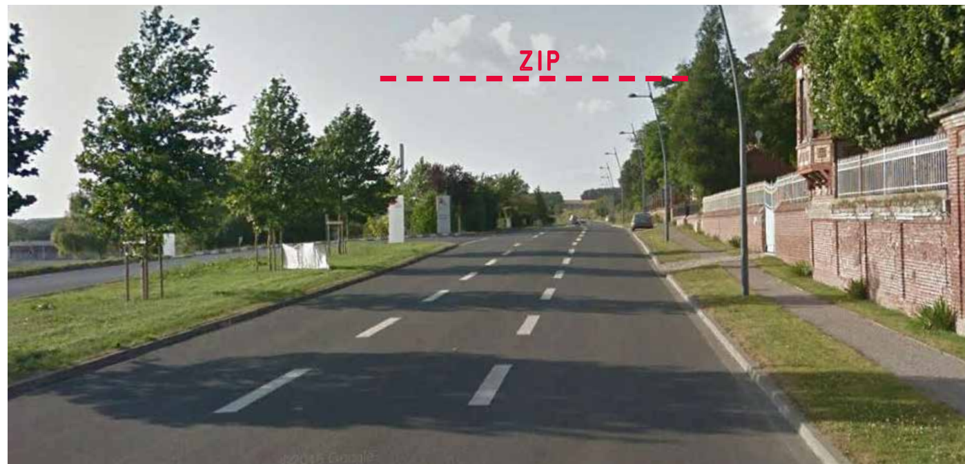
Photo 61 : Depuis la sortie nord-ouest de Pierrepont-sur-Avre, sur la RD 935 orientée en direction de la ZIP, le paysage accueillant le projet est visible à l'horizon
